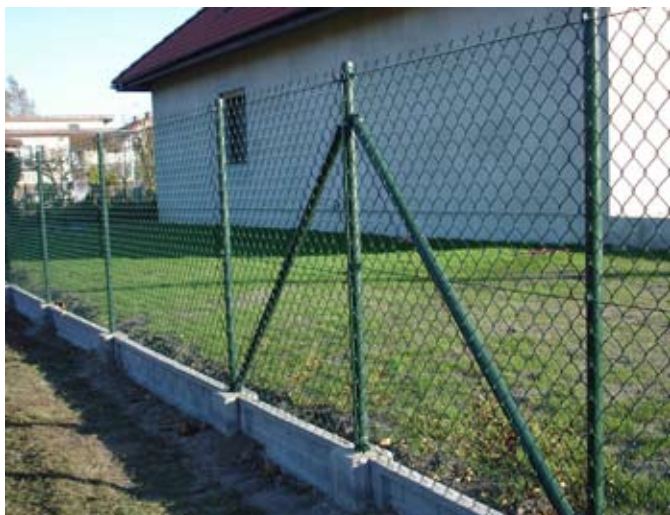
fot. 2. Siatka musi być przy słupkach narożnych wzmocniona prętami. Słupki te mogą mieć podpory pod różnym kątem.
