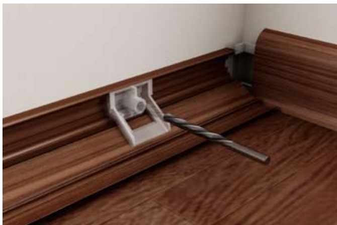
fot. 3. Do mocowania listew do ściany służą kołki rozporowe oraz wkręty z płaską główką.
