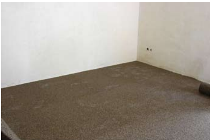
fot. 1. Większość podłoży mineralnych wymaga gruntowania. Preparat musi być наносzony równomiernie na całej powierzchni. W miejscach mocniej nasączonych powstaną plamy i zacieki.
