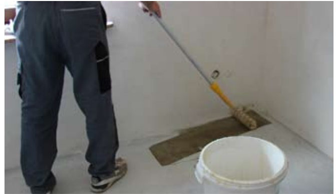
fot. 5. Jeśli ściana była nierówno nasączona preparatem, na tapecie mogą pojawić się plamy. Jest to wynikiem nierównomiernego wchłaniania kleju.
