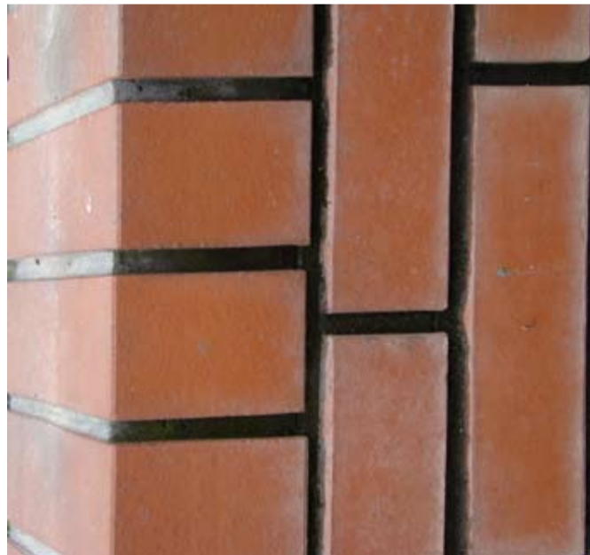
fot. 7. Jeśli podłoże było prawidłowo i starannie zaimpregnowane, często wystarczy tylko jedna warstwa farby, aby zostało równo pokryte.
