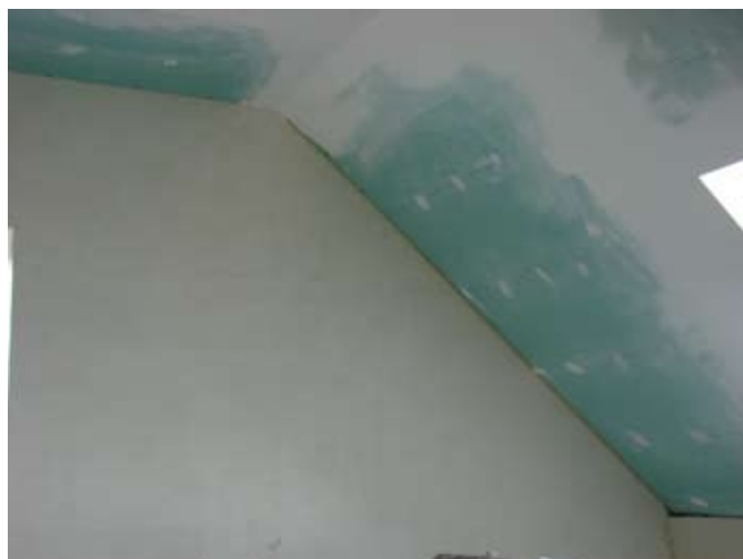
fot. 2. Płyty gipsowo-kartonowe należy przed nanoszeniem impregnatu starannie zaszpachlować.
