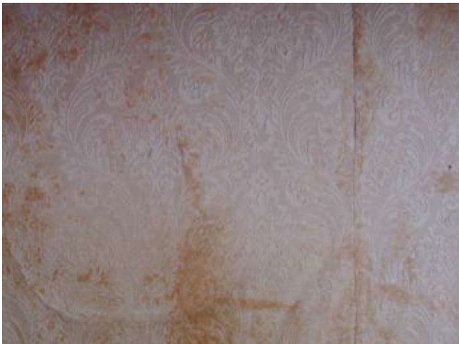
fot. 4. Wszelkie ubytki w podłożu betonowych trzeba wcześniej wypełnić lub naprawić.
