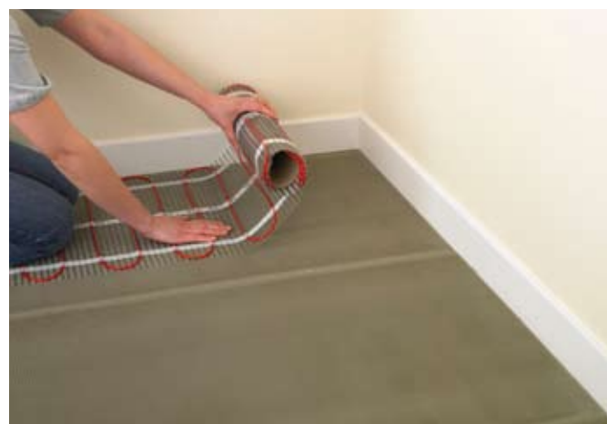
fol. 3. Mata grzejna jest samoprzylepna co umożliwia trwałe przytwierdzenie jej do podłoża.
