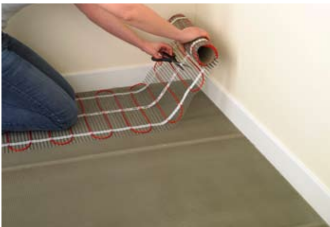
fot. 4. Matę nacina się nożyczkami technicznymi tak, aby nie uszkodzić kabla.
