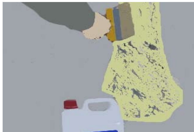
fot. 1. Zainfekowane grzybem miejsca należy powlec preparatem grzybobójczym.
