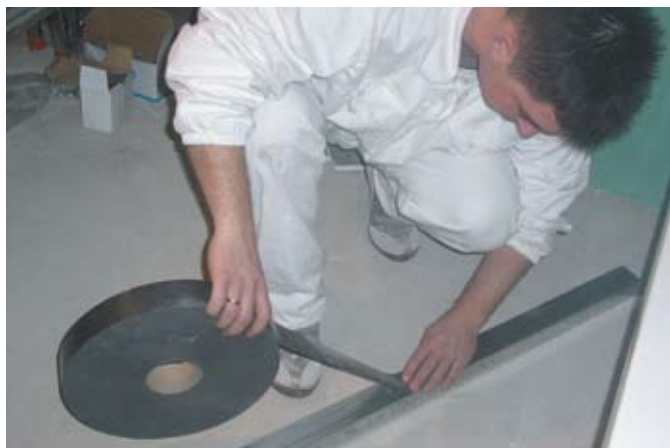
fot. 2. Wszystkie profile stykające się z konstrukcją budynku muszą być podklejone taśmą izolującą akustycznie.
