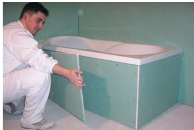
fot. 8. Górną krawędź płyty gipsowo-kartonowej należy wsunąć pod rant wanny.
