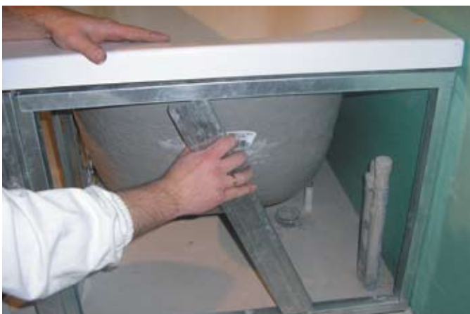
fot. 6. Słupki pionowe muszą być o 1 cm krótsze niż odległość między profilami poziomymi, w przeciwnym razie nie da się ich ustawić.
