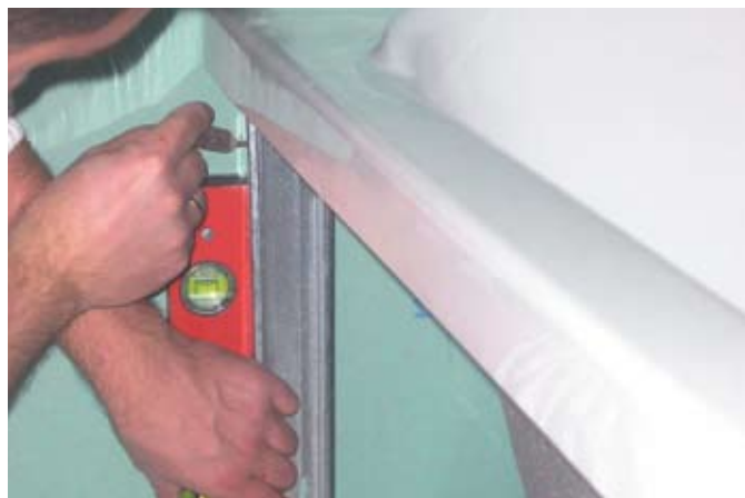
fot. 4. Staranne spionowanie jest szczególnie istotne w przypadku skrajnych słupków, które zamykają ramę stelaża.
