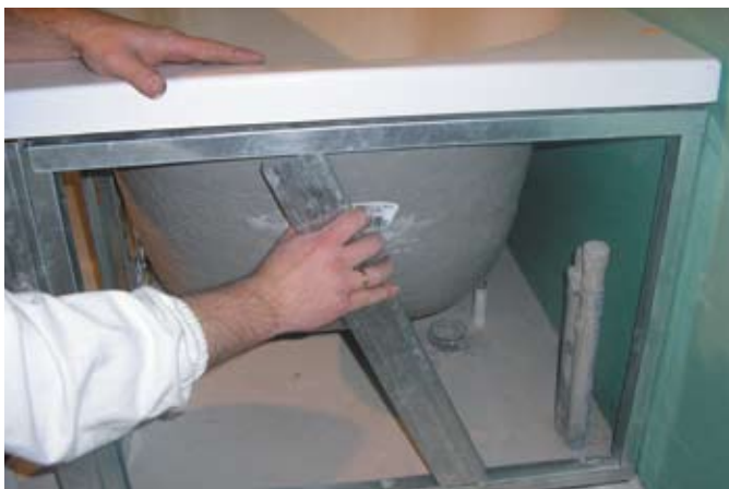
fot. 5. Profil górny nakłada się na elementy pionowe i skręca z nimi.
