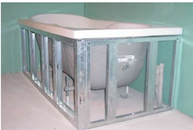
fot. 7. Gotowy stelaż musi być całkowicie prosty i stabilny.
