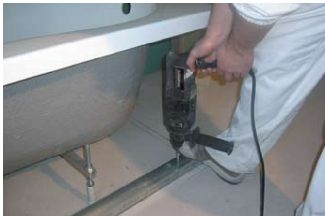
fot. 3. Profil dolny mocuje się wkrętami montażowymi, wprowadzając je w uprzednio nawiercone otwory.
