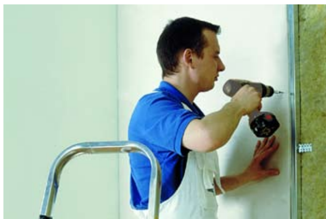
fot. 7. Płyty okładzinowe mocuje się wyłącznie do profili CD.
