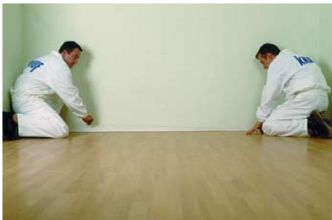
fot. 1. Do wyznaczania przebiegu stelaża za pomocą sznurka traserskiego potrzebne są dwie osoby.
