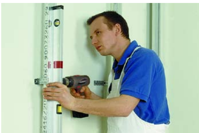
fot. 5. Starannie ustawiony w pionie profil przykręca się do łącznika.
