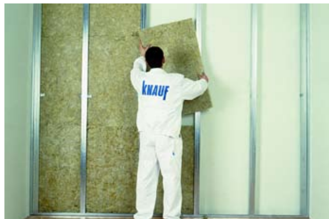
fot. 6. Materiał izolacyjny musi mieścić się pomiędzy profilami na wcisk; nie mogą pozostać żadne puste przestrzenie.
