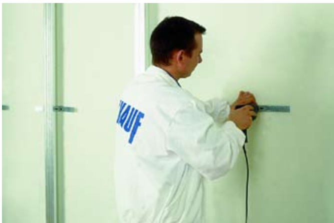
fot. 4. Pionowe profile CD są mocowane do ściany za pośrednictwem łączników ES.
