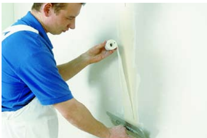
fot. 8. Ostatnim etapem prac jest przygotowanie płyt pod ostateczne wykończenie; na tym etapie najważniejsze jest wypełnienie spoin.
