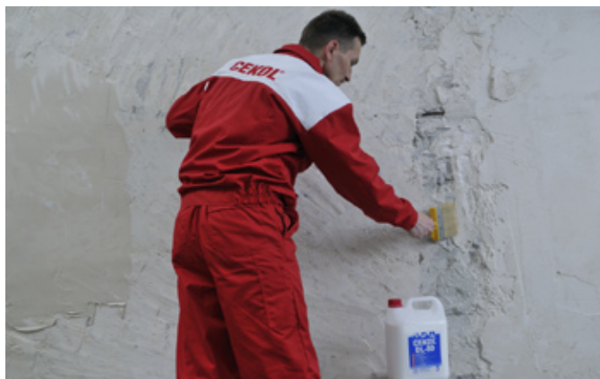
fot. 3. Podłoża chłonne należy zagruntować.
