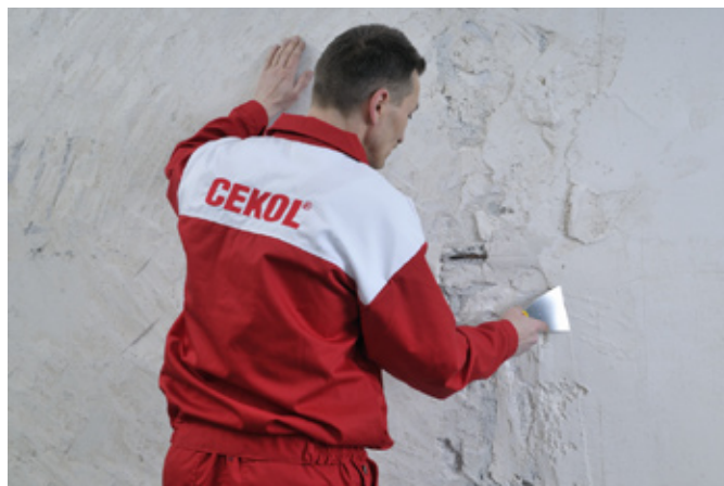
fot. 2. Wypełnienie ubytków to jedna z ważniejszych czynności przygotowawczych; prace prowadzi się tak samo, jak na płaszczyznach pionowych.
