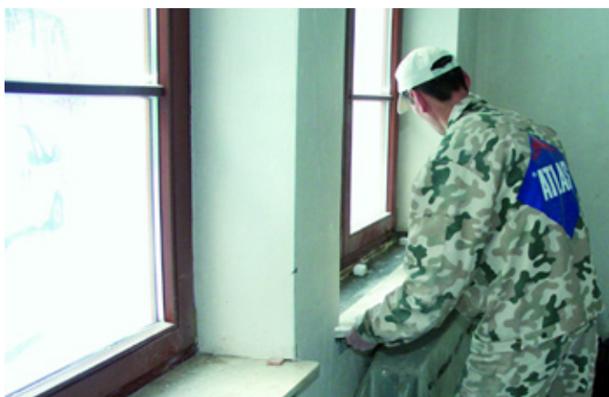
fot. 1. Mimo że parapet jest przygotowywany na wymiar, trzeba go dokładnie przymierzyć przed montażem.
