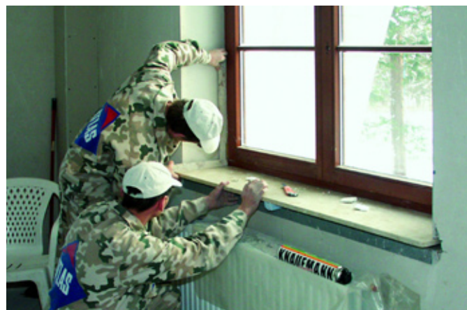
fot. 3. Parapet nie może mieć spadku w kierunku okna; sprawdza się to kątem.
