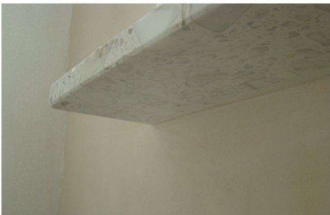
fot. 4. Jeśli parapet jest prawidłowo osadzony, także pod spodem nie ma żadnej szczeliny (fot. Hanna Czerska).
