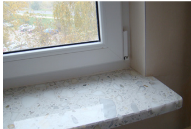
fot. 5. Ostatnim etapem prac jest otynkowanie ściany na styku z parapetem (fot. Hanna Czerska).
