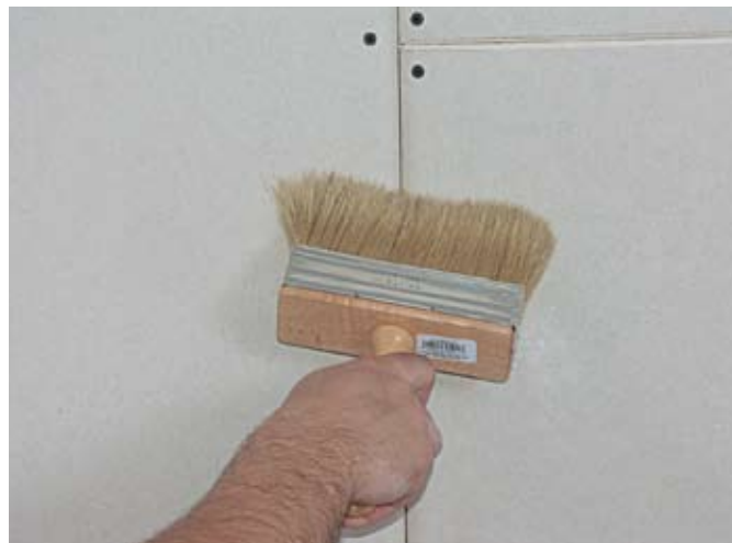
fot. 1. Prace przy wypełnianiu spoin między płytami gipsowo-kartonowymi rozpoczyna się od dokładnego ich odpylenia.
