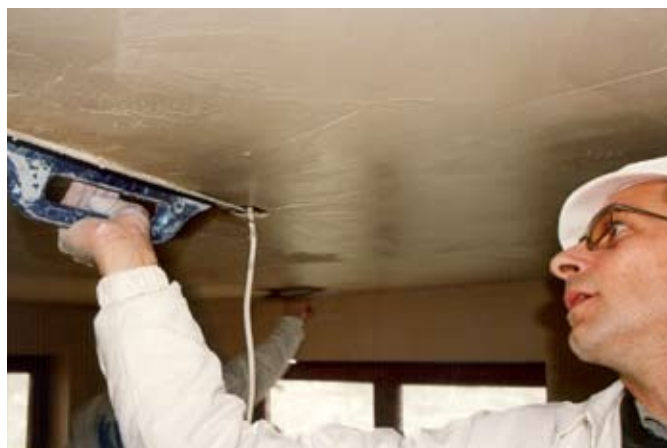
fot. 6. Połączenia płyt na suficie szpachluje się tak samo, jak na ścianie. Następnie trzeba dokładnie pokryć cienką warstwą masy całą powierzchnię.
