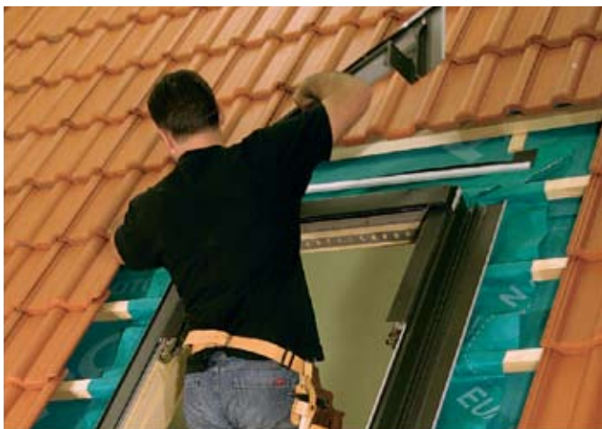
fot. 9. Uszczelnianie okna kończy przykręcenie górnej części kołnierza oraz kaptura.
