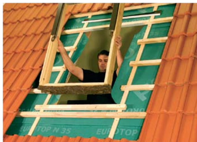
fot. 4. Materiał termoizolacyjny likwiduje szczelinę nad i pod oknem.
