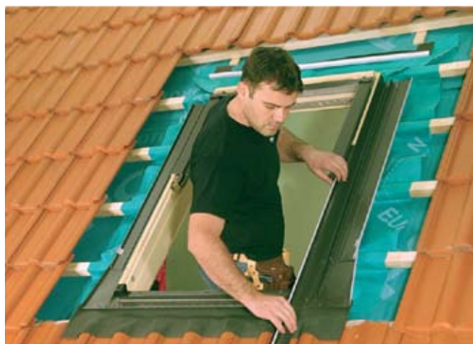
fot.8. Wraz z elementami bocznymi kołnierza mocuje się maskowanie ościeżnicy.
