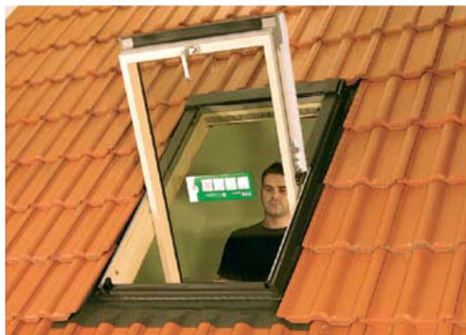
fot. 12. Montaż okna kończy założenie skrzydła i sprawdzenie jego działania.
