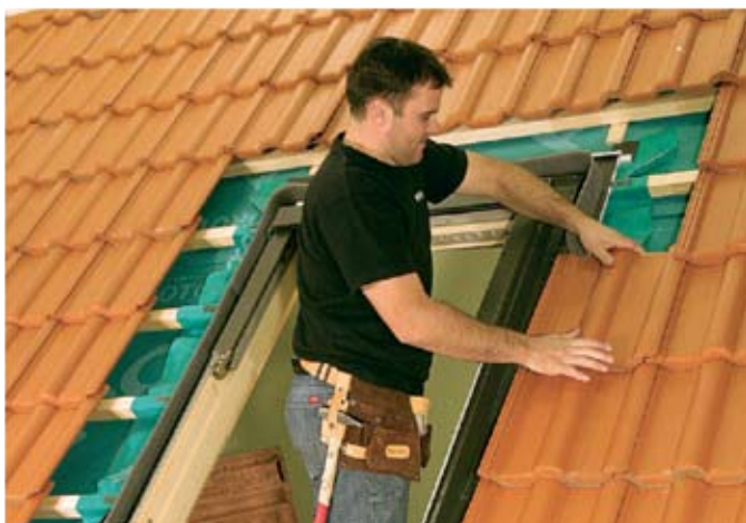
fot. 11. Gdy ościeżnica jest już zamontowana, trzeba zamontować pokrycie dachu.
