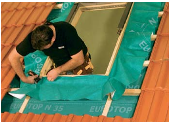
fot.6. Termoizolacja musi być chroniona folią paroprzepuszczalną, z której formuje się kołnier.
