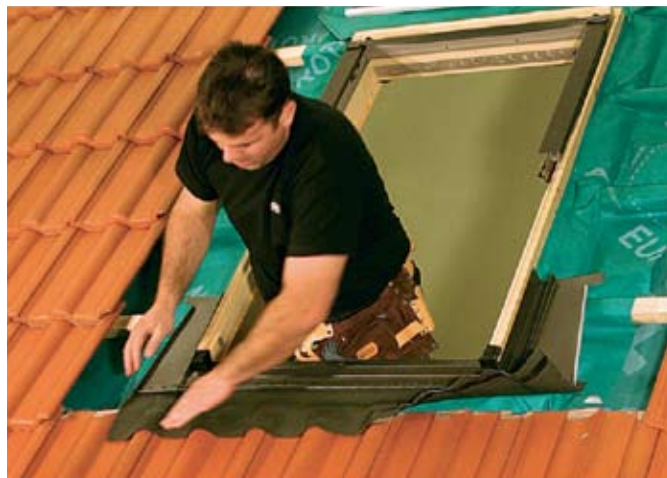
fot.7. Najpierw montuje się część kołnierza uszczelniającego pod oknem.
