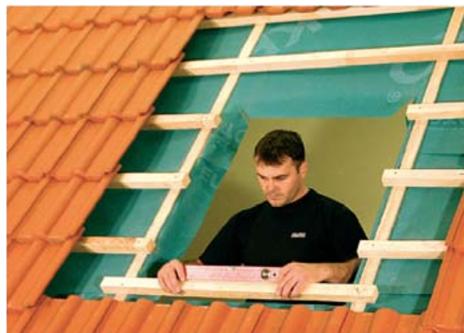
fot. 3. Okno przytwierdza się do łąt montażowych, które muszą być wypoziomowane.
