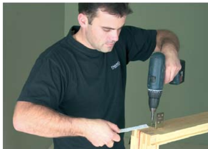
fot. 2. Przykręcając kątowniki trzeba pamiętać o zamocowaniu ich na odpowiedniej wysokości.
