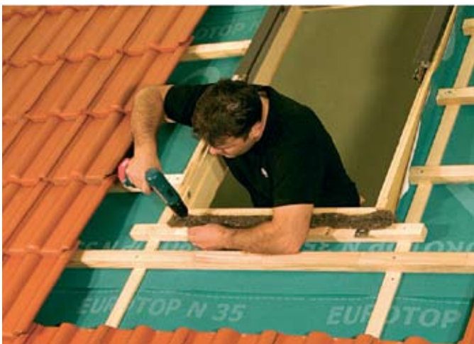
fot.5. Ościeżnicę najpierw przykręca się do dolnej łąty, a następnie sprawdza wielkość szczeliny wokół okna.
