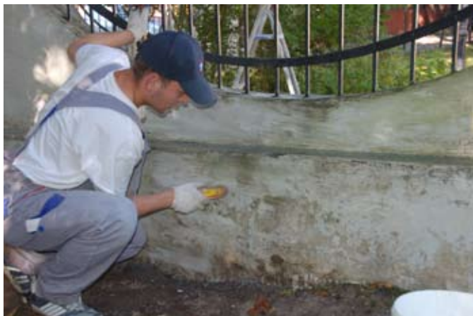
fot. 1. Staranne oczyszczenie betonowych części płotu sprawi, że zaprawa będzie dobrze przylegała i remont wystarczy na długo.
