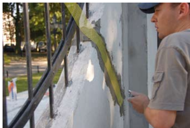
fot. 4. Głębsze pęknięcia wzmacnia się siatką zbrojącą - konieczne jest dokładne zatopienie jej w zaprawie.
