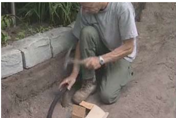
fot. 5. Brzeg folii musi być stabilny - proponujemy konstrukcję z kołków i elastycznej rury
