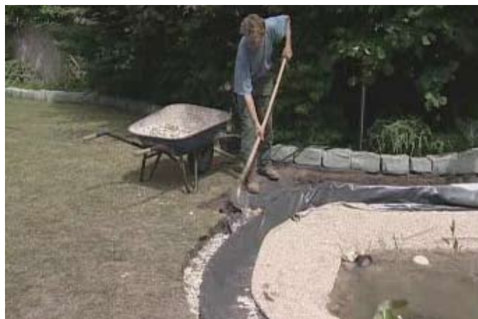
fot. 7. Krawędzie folii należy obciążyć i umocować żwirem.
