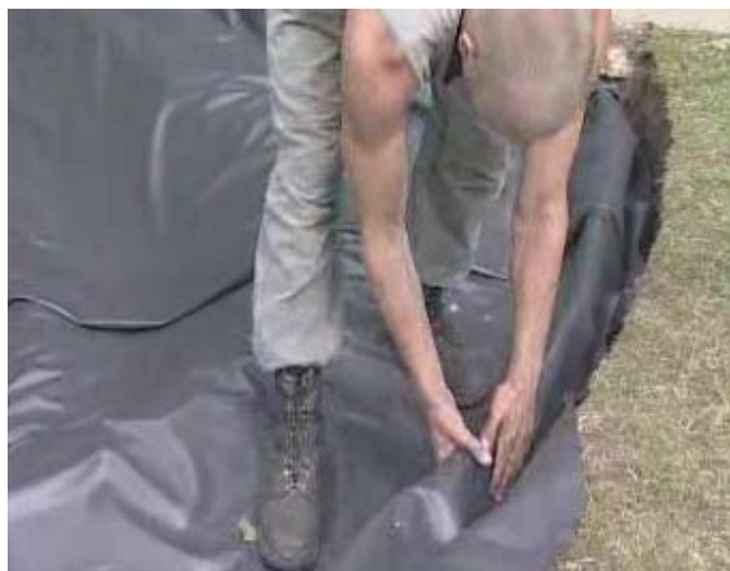
fot. 6. Jeden z ważniejszych momentów - dokładne ułożenie brzegu folii.
