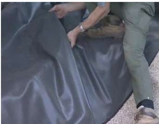
fot. 4. Wąż doprowadzający wodę można schować w fałdzie folii.
