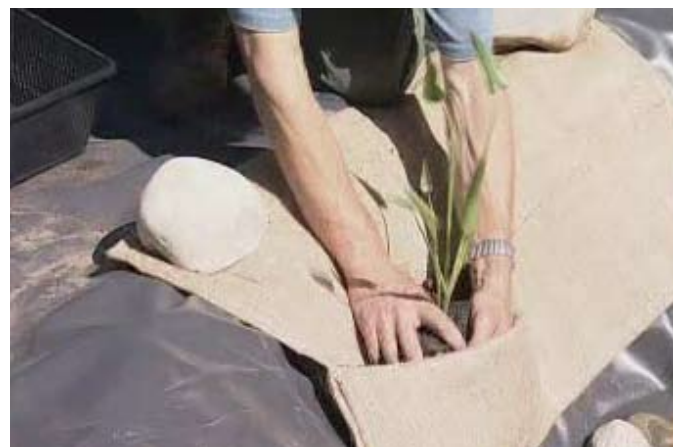
fot. 10. Rośliny sadzi się w specjalnych pojemnikach oraz kieszeniach z tkaniny.
