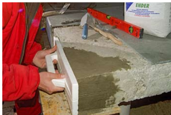
fot. 6. Wyprowadzanie krawędzi płyty balkonowej czy tarasowej jest najtrudniejsze.
