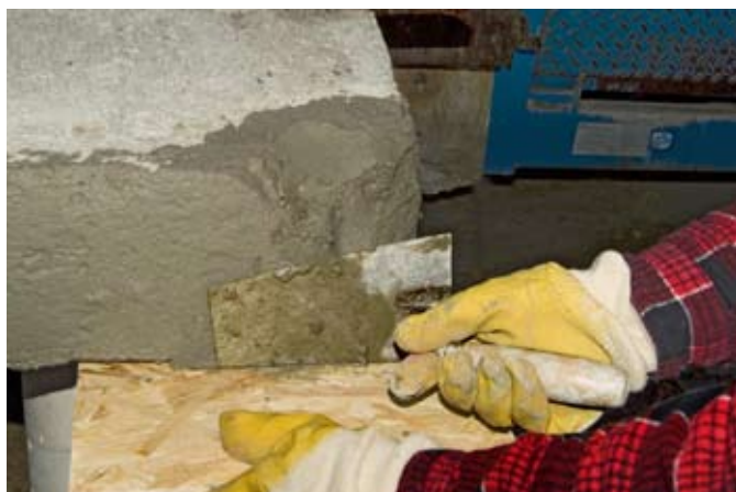
fot. 5. Zaprawa wyrównawcza jest podstawowym składnikiem systemu; musi szczelnie wypełnić wszystkie ubytki.
