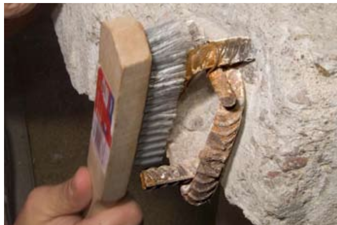
fot. 2. Pręty zbrojeniowe trzeba starannie oczyścić drucianą szczotką.
