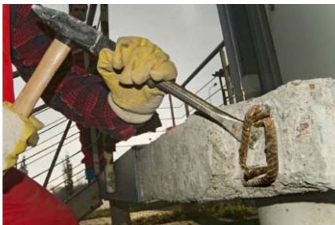
fot. 1. Do odkucia odkrytych fragmentów zbrojenia wystarczą przecinak i młotek.
