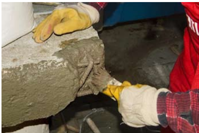
fot. 4. Warstwa kontaktowa musi zostać bardzo dokładnie wtrąta w beton i odkryte zbrojenie.
