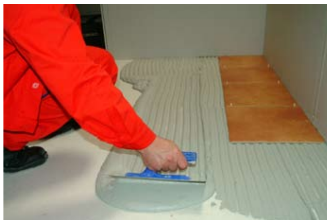
fot. 1. Zaprawę klejową rozprowadza się na podłożu pacą zębatą.
