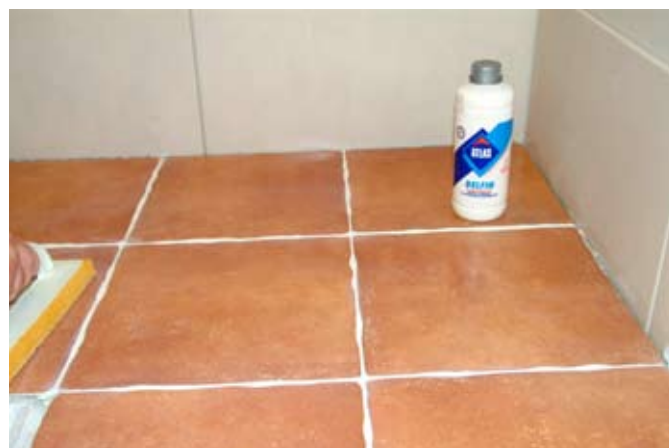
fot. 10. Zaimpregnowanie powierzchni nowej posadzki sprawi, że wolniej będzie się ona brudzić.
