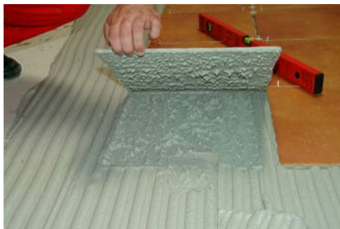
fot. 2. Klej powinien dobrze pokryć zarówno podłoże, jak i kafelek.
