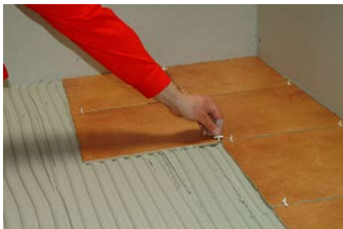
fot. 3. Krzyżyki dystansowe pozwalają wykonać równą spoinę między płytkami.
