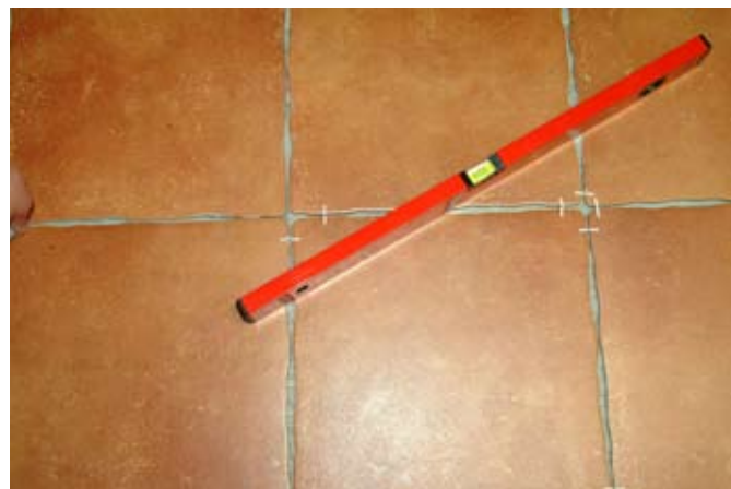
fot. 6. Podczas pracy trzeba sprawdzać wypoziomowanie kafelków.
