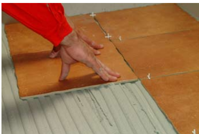
fot. 4. Każdą płytkę trzeba docisnąć na całej jej powierzchni.
