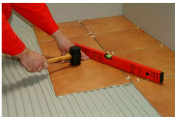
fot. 5. Większe płytki delikatnie dobija się gumowym młotkiem.
