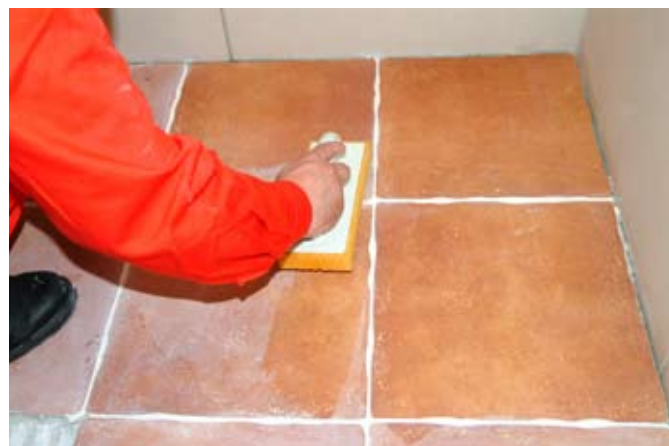
fot. 9. Zanim fuga stwardnieje, konieczne jest oczyszczenie powierzchni płytek z jej resztek.
