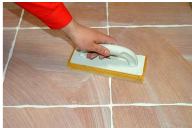
fot. 8. Jeszcze plastyczną masę wyrównuje się pacą.
