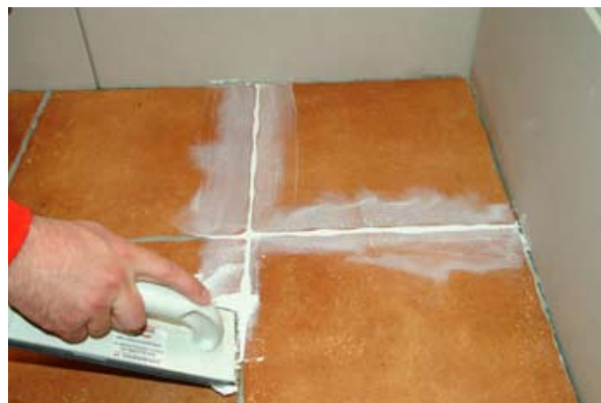
fot. 7. Fugę trzeba dokładnie wcisnąć w spoinę.
