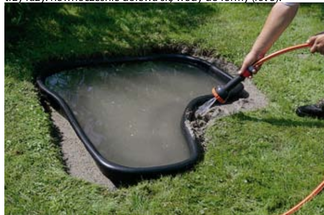
fot. 3. Podczas osadzania formy musi być ona wypełniona wodą.
