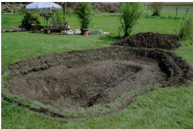
fot. 1. Po odwzorowaniu kształtu formy na ziemi przystępuje się do robienia wykopu.
