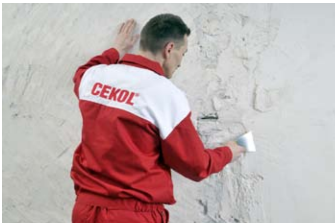
fot. 3. Do uzupełniania ubytków służy masa szpachlowa, którą nakłada się metalową szpachelką.
