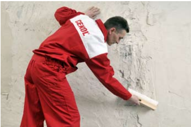
fot. 1. Pierwszym etapem przygotowywania każdego podłoża jest jego staranne oczyszczenie.
