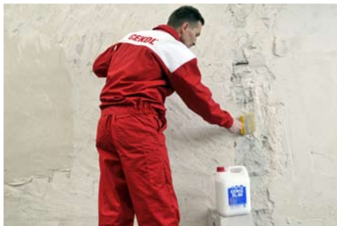
fot. 2. Wszelkie podłoża porowate należy zagruntować.
