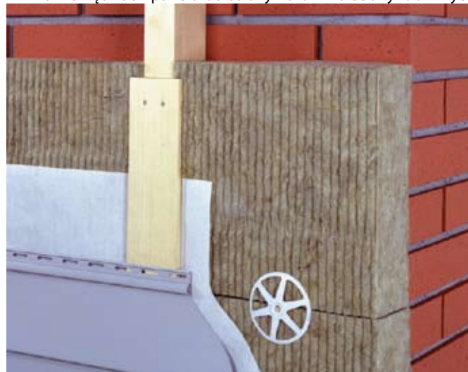
fot. 3. Panele winylowe mocuje się do rusztu, wbijając gwoźdź w środek podłużnego otworu u góry elementu; jeśli dom jest ocieplany, wełna mineralna musi być ostonięta folią izolacyjną.
