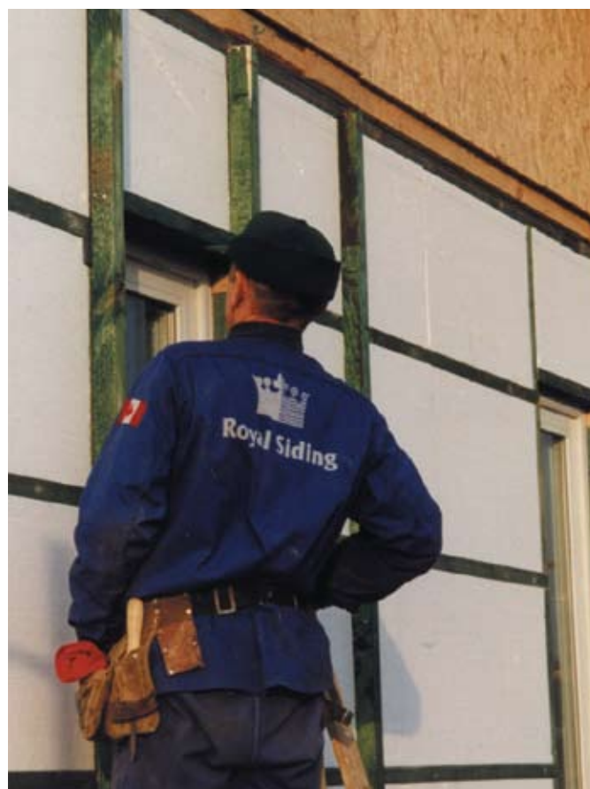
fot. 1. Montaż sidingu poprzedza przygotowanie drewnianego rusztu; materiał powinien być zaimpregnowany.
