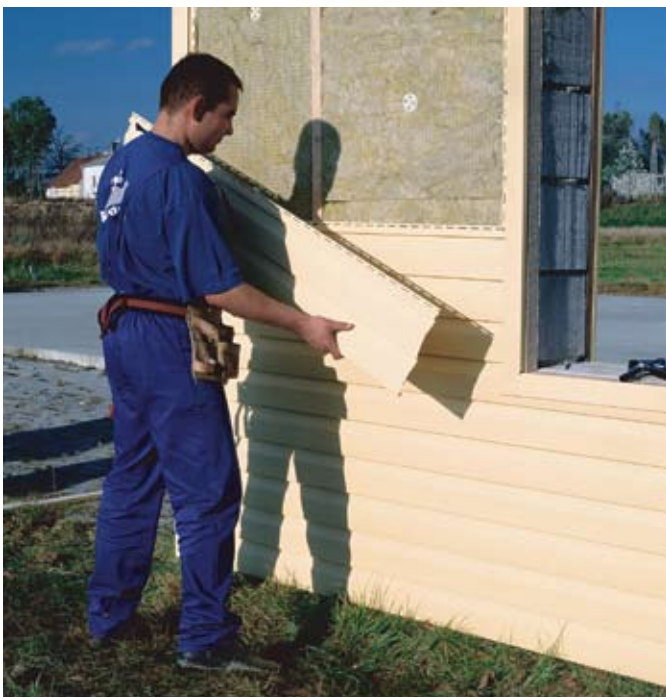
fot. 2. Siding mocuje się od dołu ściany
