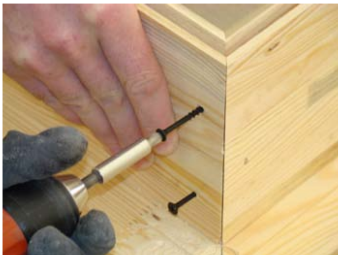
fot. 1. Elementy ościeżnicy łączy się wkrętami do drewna.
