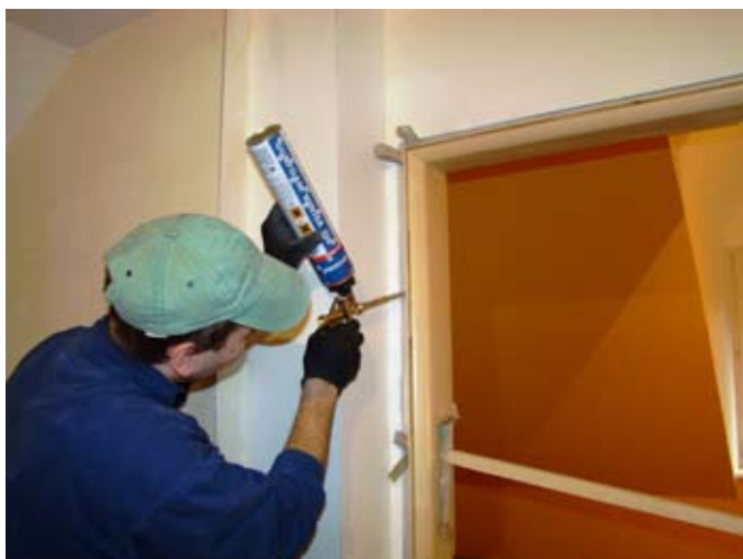
fot. 5. Drewniane listwy rozpierają ościeżnicę, przeciwdziałając naporowi rozprężającej się pianki montażowej.
