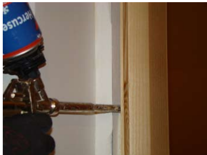
fot. 6. Piankę należy dozować z umiarem, by nie wypchnęła ościeżnicy.
