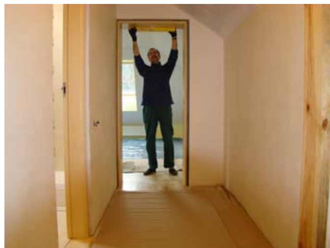
fot. 3. Ościeżnica musi być idealnie wypoziomowana, w przeciwnym razie drzwi nie będą płynnie się otwierały.
