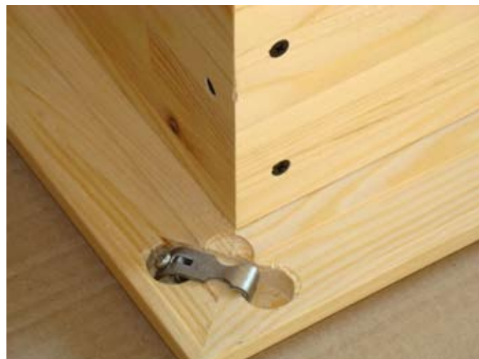
fot. 2. Po zmontowaniu ościeżnicy trzeba połączyć wykańczającą ją opaskę.
