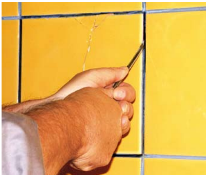
fot. 1. starą fugę usuwa się specjalnym skrobakiem
