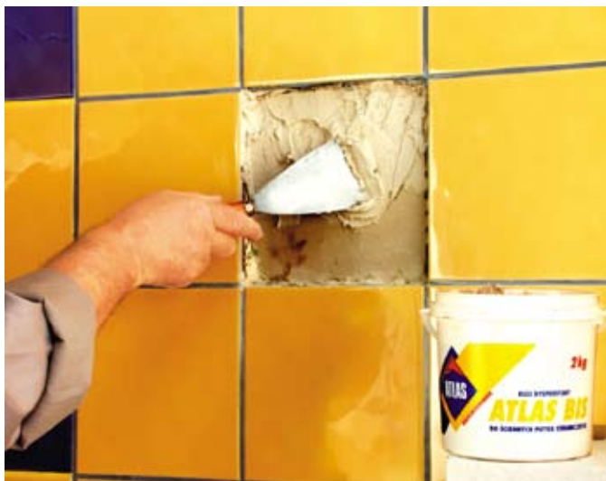
fot. 5. zaprawę trzeba rozprowadzić równą warstwą
