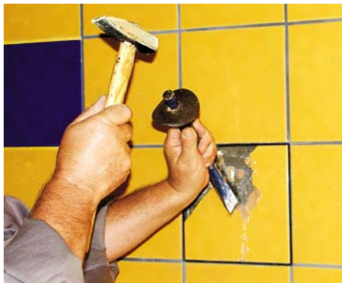
fot. 2. skuwanie uszkodzonego kafelka zawsze zaczynamy od jego środka
