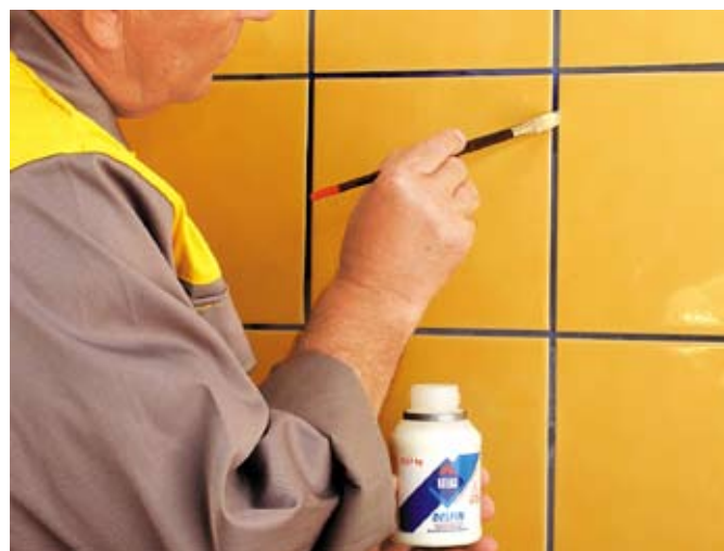
fot. 8. impregnat sprawia, że w fugę znacznie wolniej wnika brud
