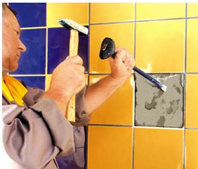
fot. 3. po oczyszczeniu podłoże musi być równe
