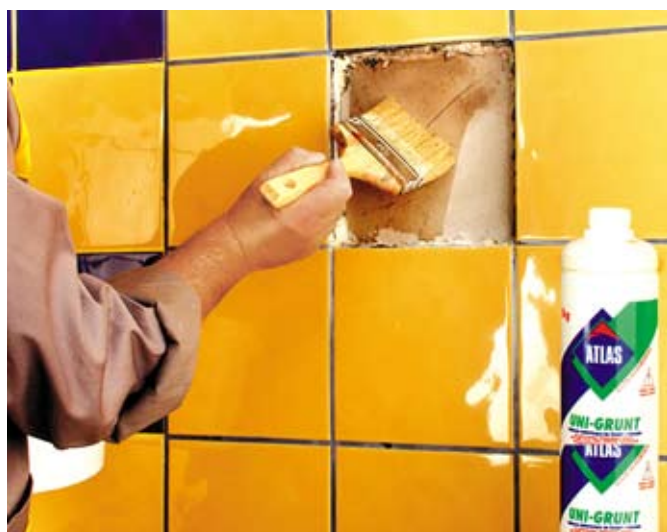
fot. 4. gruntowanie zwiększa przyczepność zaprawy klejowej
