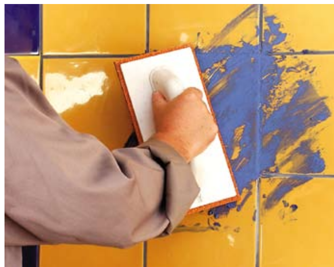
fot. 7. fachowcy tak zacierają fugę - konieczne jest tylko natychmiastowe oczyszczenie płytek
