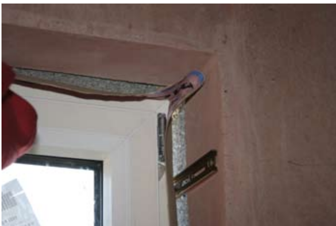
fot. 4. Rozprężna taśma uszczelniająca wypełnia przestrzeń między oknem a murem.
