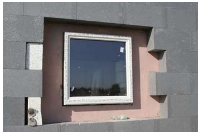
fot. 1. Okno musi być zamontowane do muru nośnego.
