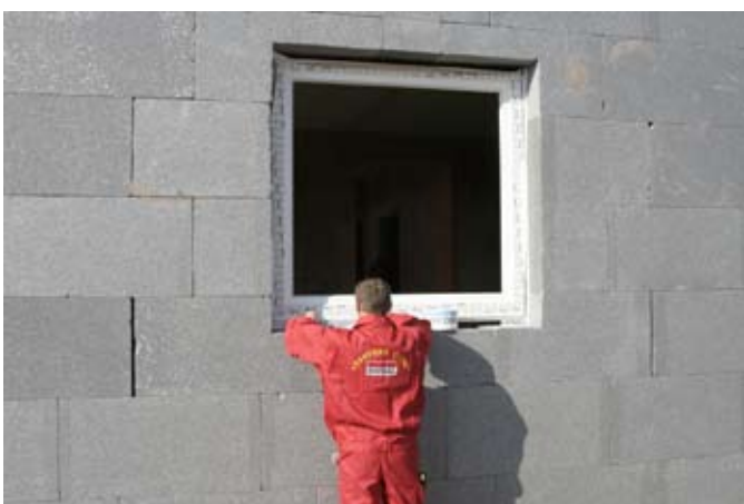
fot.5. Taśma paroprzepuszczalna izoluje miejsce osadzenia okna od zewnątrz. Zastąpi ją parapet zewnętrzny.
