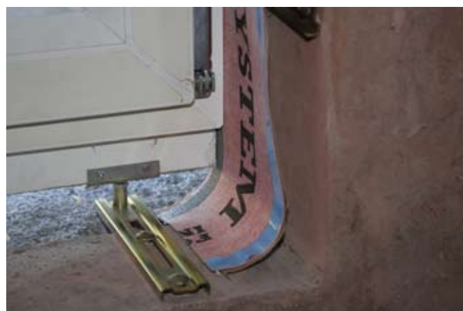
fot. 2. Metalowe podstawki z kotwami zastępują drewniane kliny stosowane przy tradycyjnym montażu okna.
