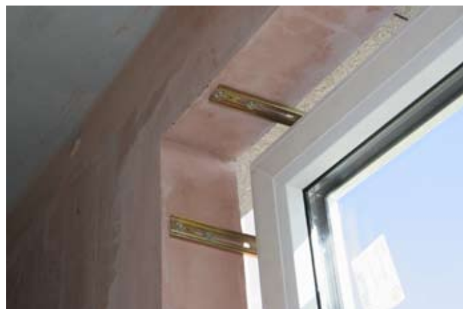
fot. 3. Kotwy przykręca się do boków ościeża.
