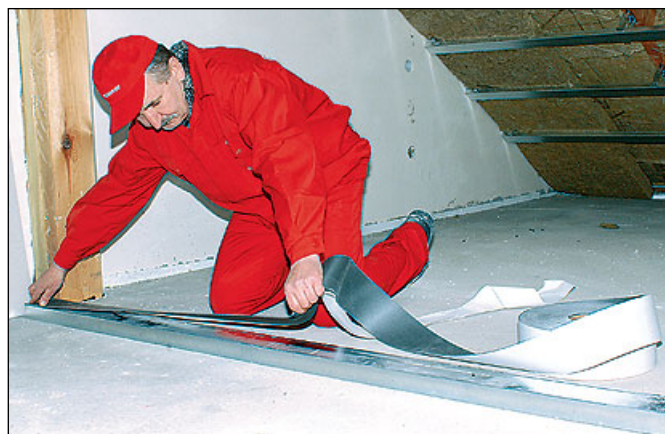
fot. 2. Umieszczona od spodu profili taśma izoluje akustycznie
