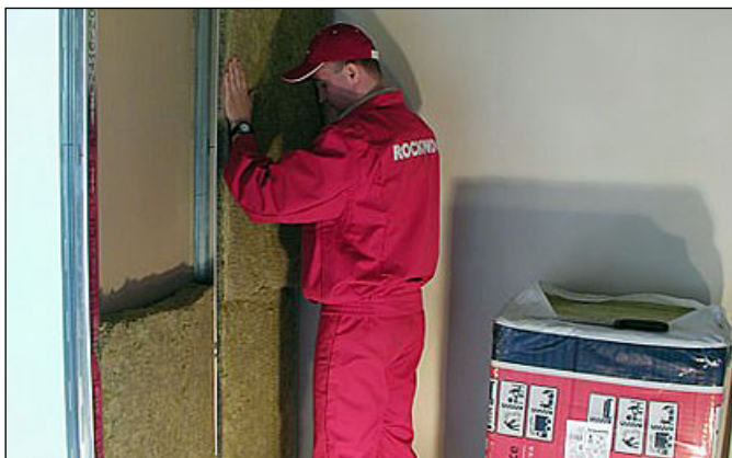
fot. 5. Wełna mineralna umieszczona wewnątrz ścianki izoluje ją akustycznie
