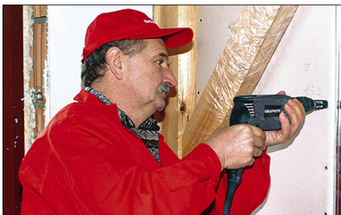
fot. 4. Mocowanie pierwszej warstwy płyt gipsowo-kartonowych.
