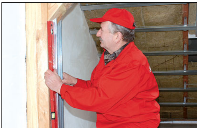
fot. 1. Przebieg profili trzeba zaznaczyć na ścianach, podłodze i suficie
