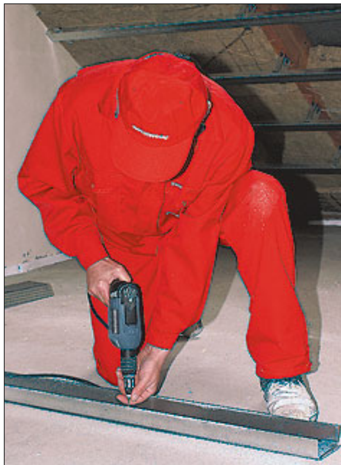
fot. 3. Montaż profili UW
