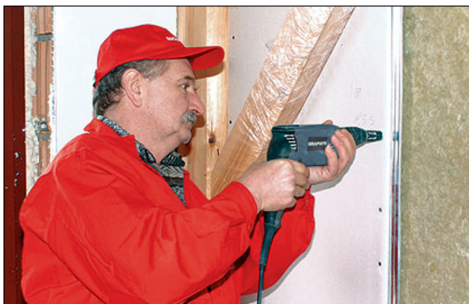
fot. 6. Montaż płyt g-k z drugiej strony ścianki działowej
