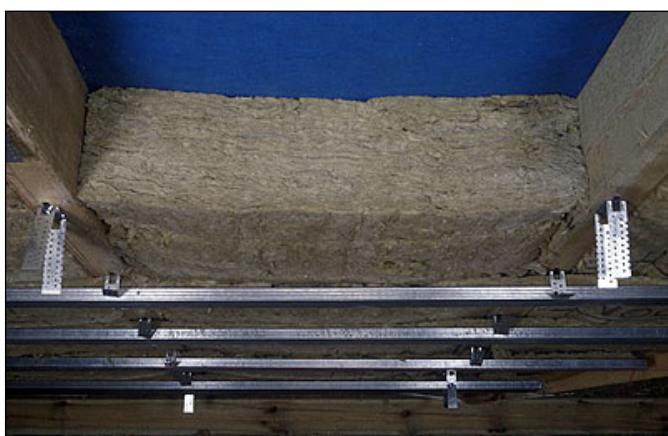
fot. 5. Stalowe profile będą oparciem dla drugiej warstwy izolacji termicznej.
