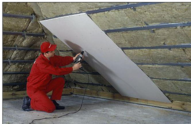
fot. 7. Do rusztu stalowego przykręca się płyty gipsowo-kartonowe.
