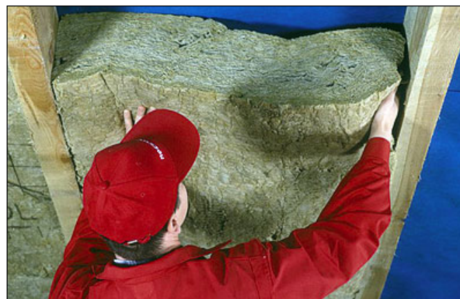
fot. 2. Izolację umieszcza się w przestrzeniach pomiędzy krokwiami na wcisk.
