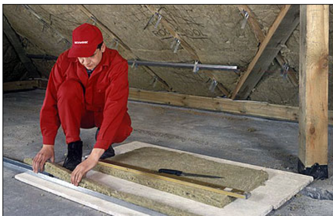
fot. 4. W profile nośne wciska się paski wełny mineralnej.
