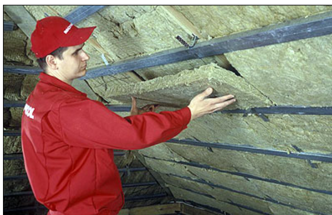
fot. 6. Pomiędzy profile nośne wciska się drugą warstwę wełny mineralnej.
